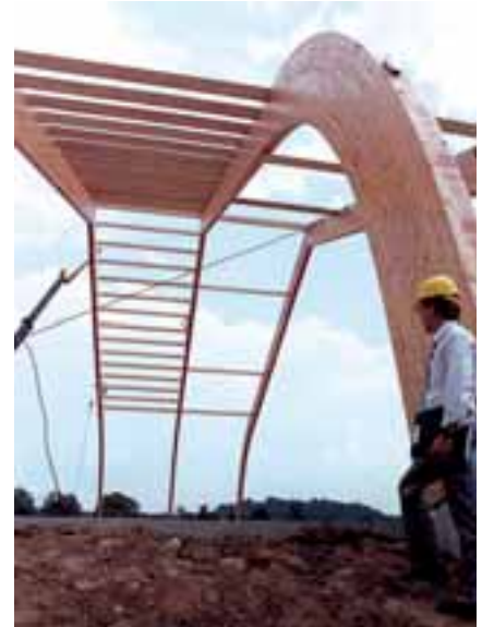
Foto 6. Arcos de vigas laminadas.
