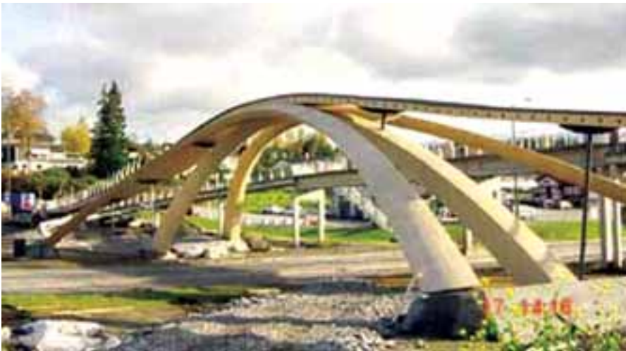
Fotos 15 y 16. Puente Leonardo, un diseño de Leonardo Da Vinci, levantado en Aldea As, (Noruega) en 2001. Armado en madera sin tratar, tiene una luz de 45 metros y un largo total de 110 metros.
