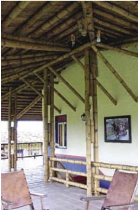
El uso de la Guadua como material constructivo fue un hecho que promovió la aplicación de esta especie en la arquitectura.
